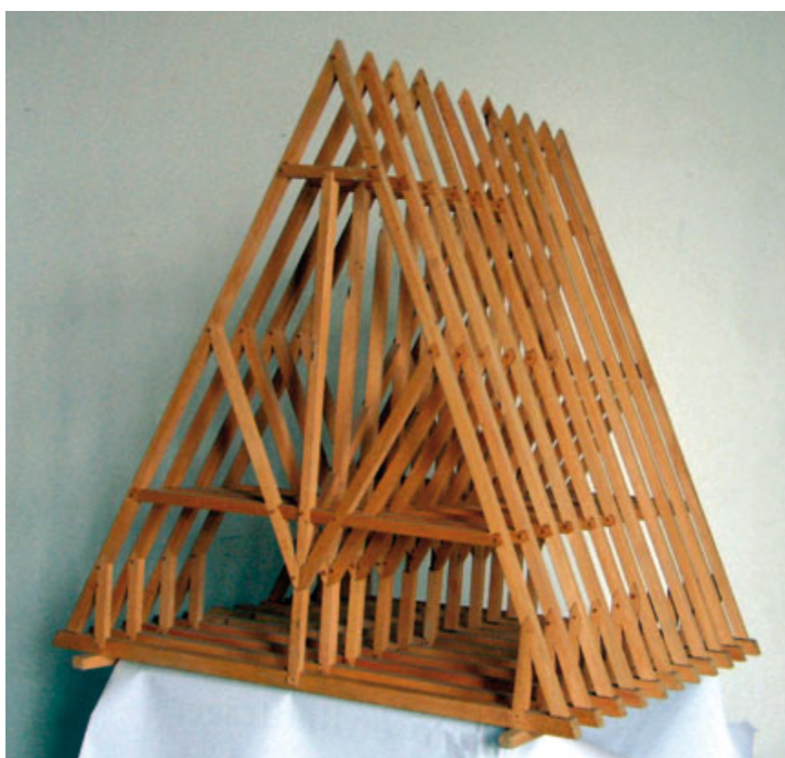
Rys. 4. Toruń. Kościół św. Jakuba. Model więźby storczykowej znad nawy głównej. Około połowy XIV w. Fot. J. Krawczyk. Modele ze zbiorów Instytutu Zabytkoznawstwa i Konserwatorstwa Uniwersytetu Mikołaja Kopernika
