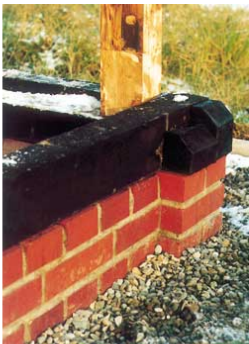
Fot. 9. Nowe posadowienie baraku obozowego - prawidłowe pod względem skuteczności ochrony drewna, lecz bardzo kontrowersyjne (najdelikatniej ujmując) ze względu na zatarcie realiów historycznych (fot. A.Krajewski)
