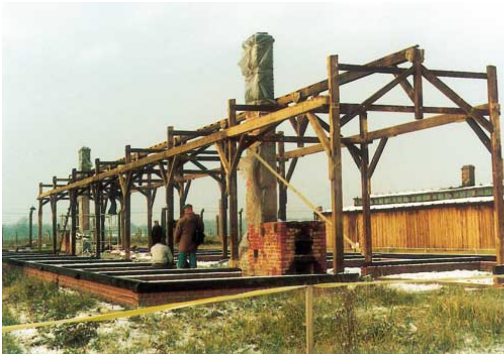
Fot. 8. Rozebrany barak obozowy w Muzeum Państwowym Oświęcim - Brzezinka, w trakcie konserwacji. Widoczna szkieletowa konstrukcja obiektu (fot. A.Krajewski)
