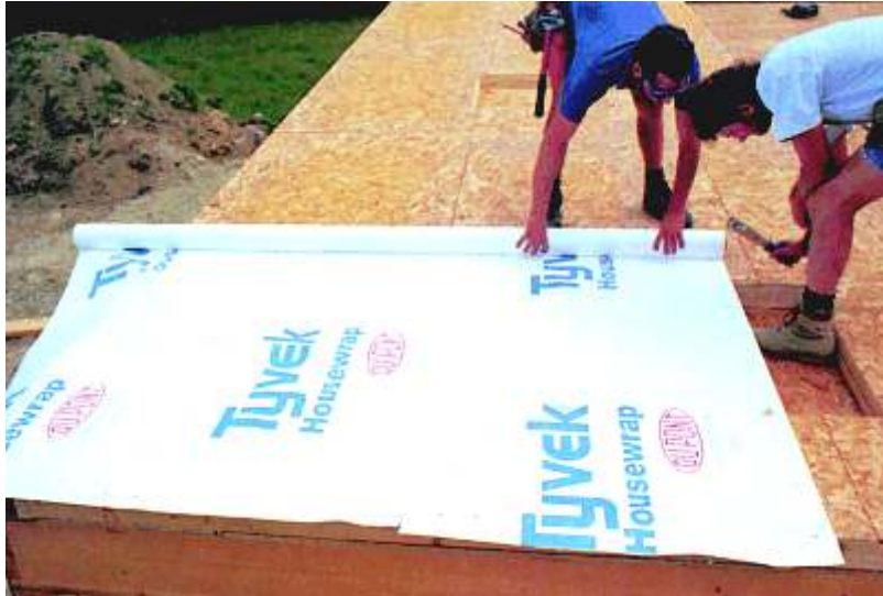
Zdjęcie nr 3. Praca w dwuosobowym zespole przebiega znacznie szybciej. Szczególnie w wietrzne dni dobrze jest gdy jedna osoba przykrywa izolację, a druga rozwija materiał.
