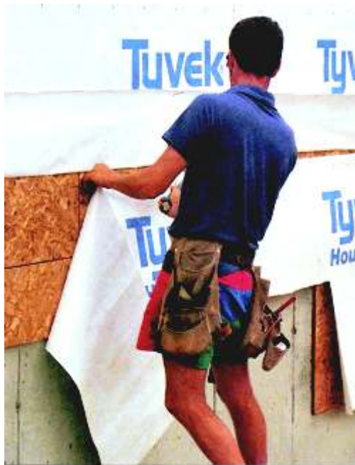
Zdjęcie nr 4. Nałożenie jednego pasma izolacji na drugie tworzy jeszcze lepszą uszczelnienie.
