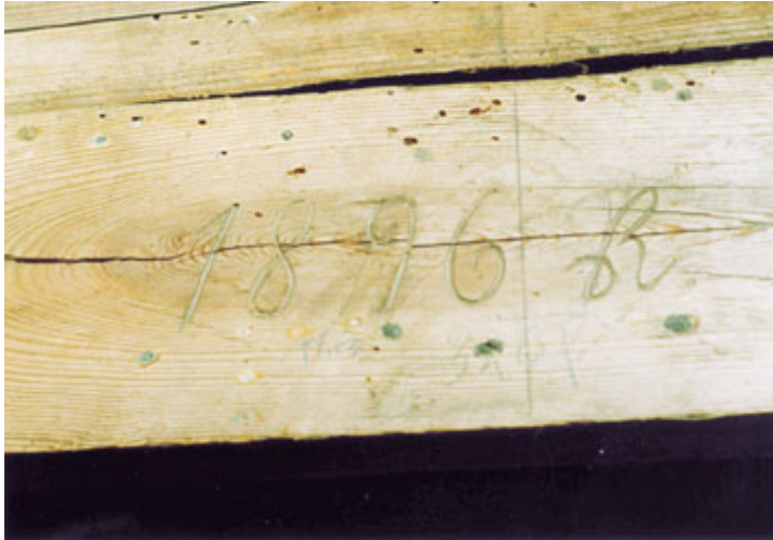
fot. 3. Stare otwory wylotowe chrząszczy spuszczała na powierzchni belki nadproża zabytkowego budynku.
