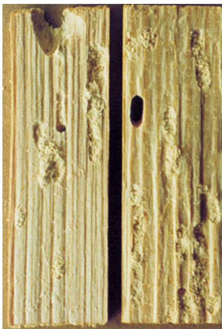
fot.4. Drewno stoczone przez larwy spuszczeła (średni stopień zniszczenia).
