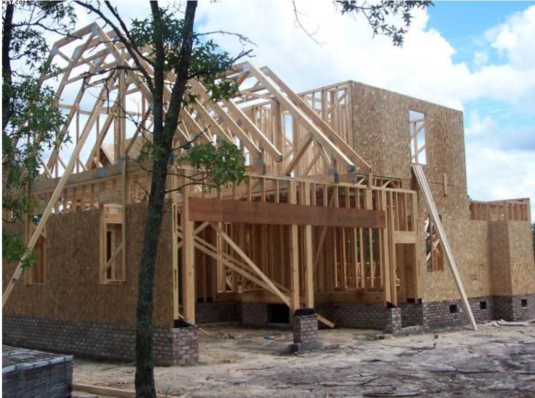
Montaż OSB
