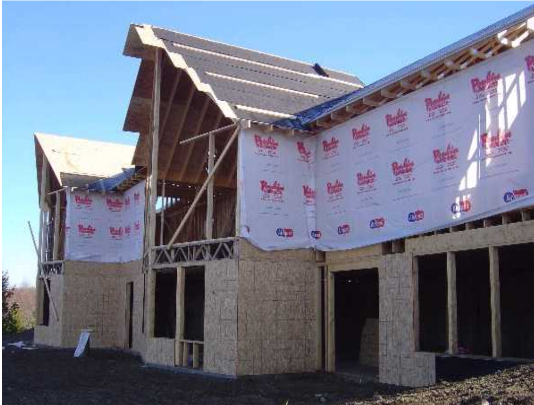
OSB i wiatroizolacja
