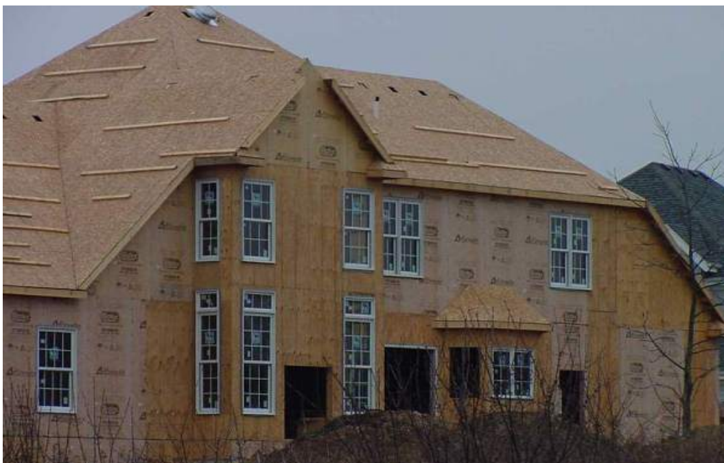
OSB na dachu
