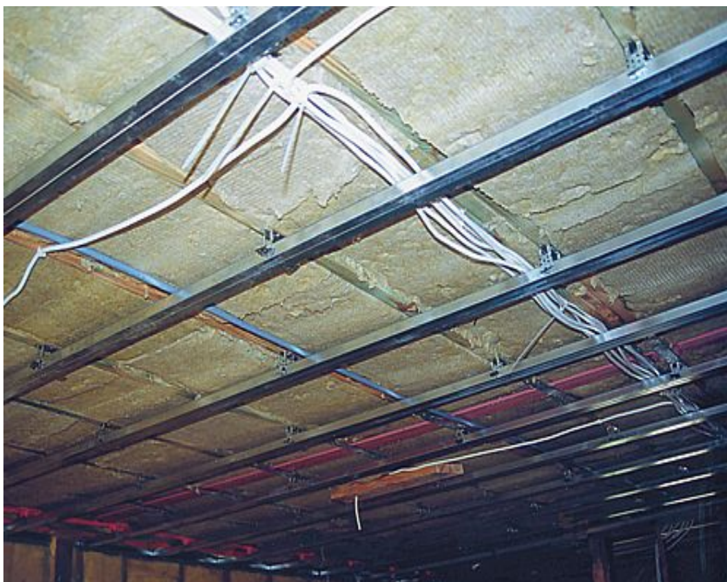
Ruszt metalowy pod płyty gipsowe
