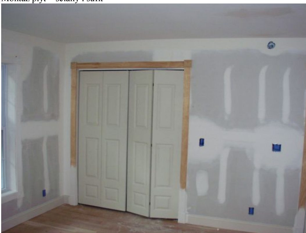
Montaż płyt – przygotowane do malowania
