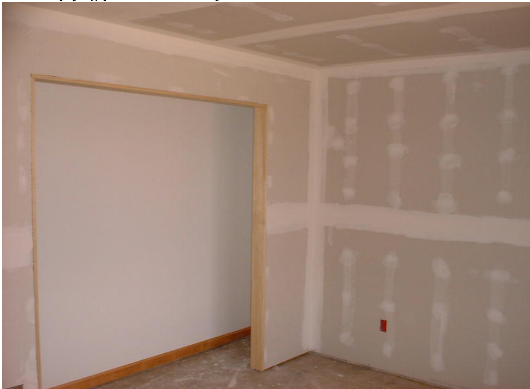
Montaż płyt – otwory drzwiowe
