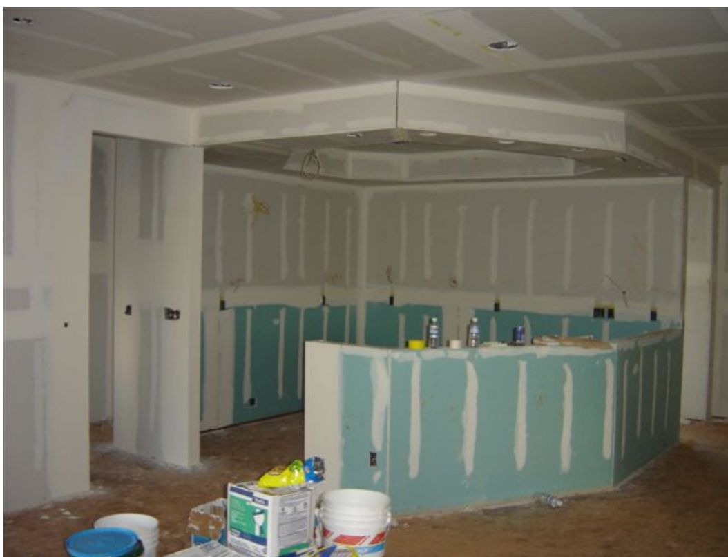
Montaż płyt - salon z aneksem kuchennym
