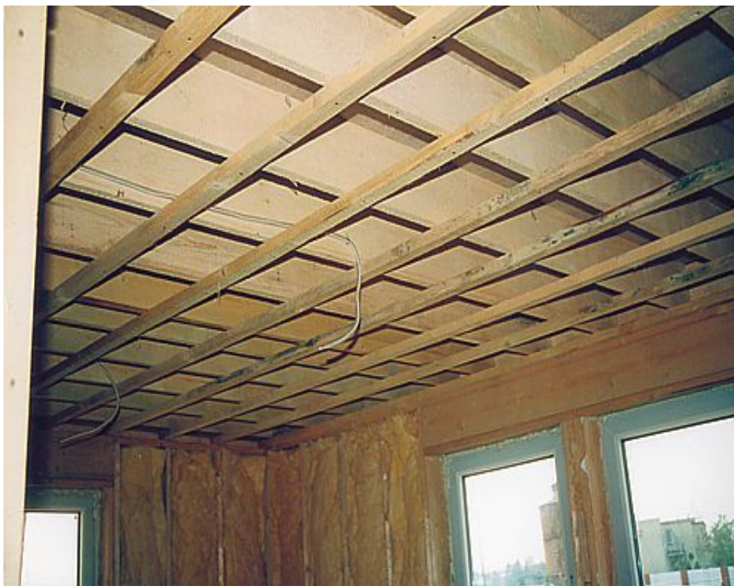
Ruszt Drewniany pod płyty gipsowe
