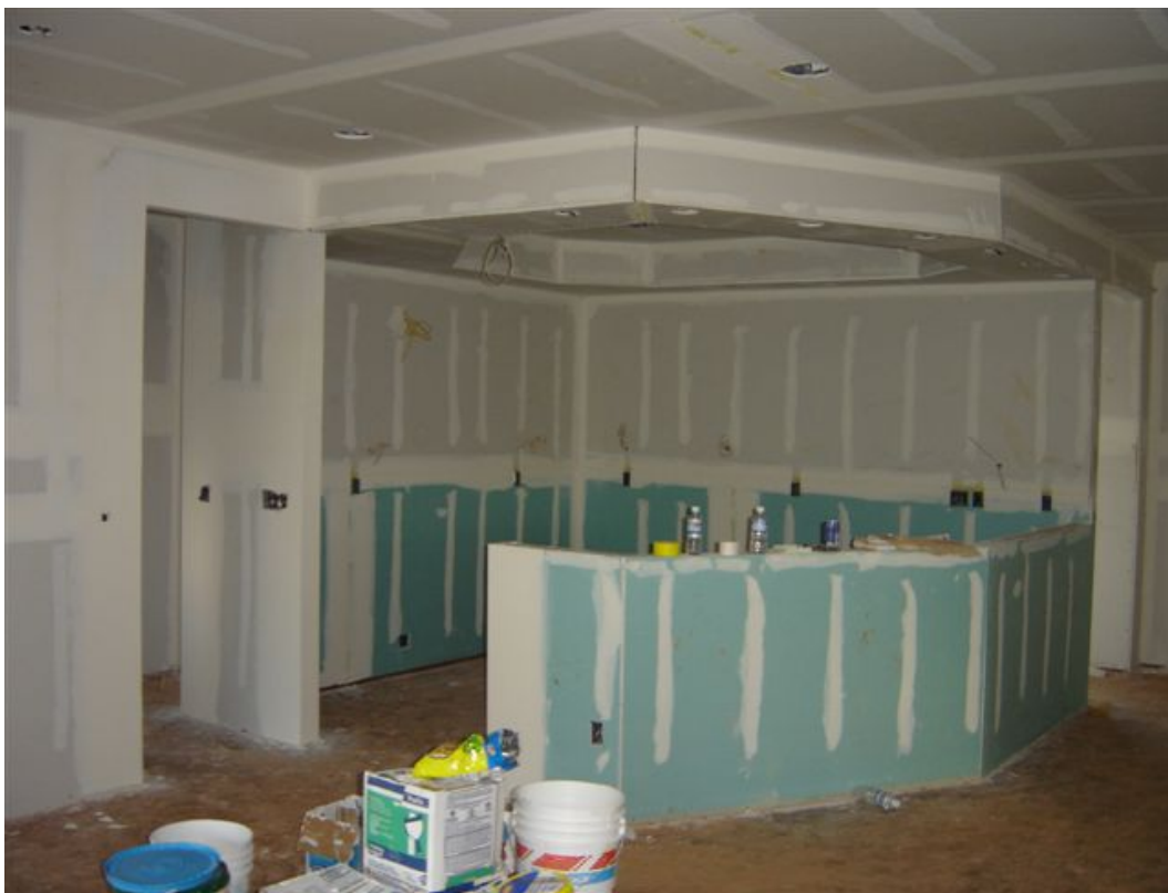
Montaż płyt - salon z aneksem kuchennym
