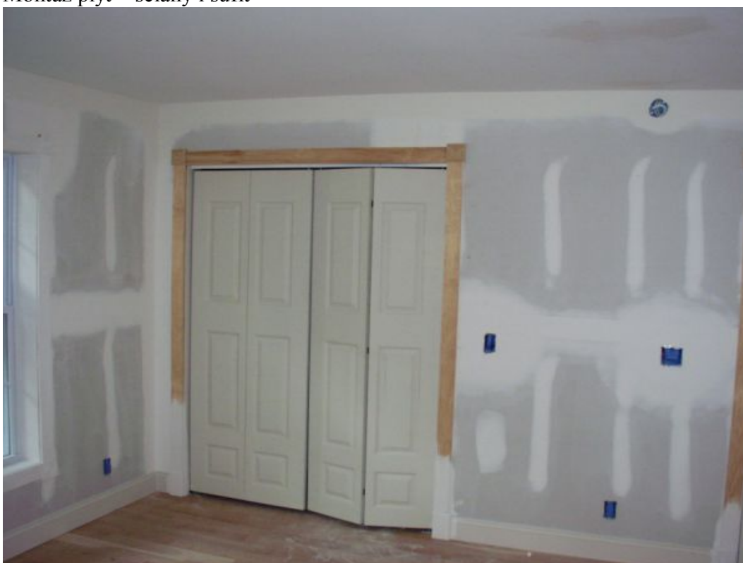
Montaż płyt – przygotowane do malowania
