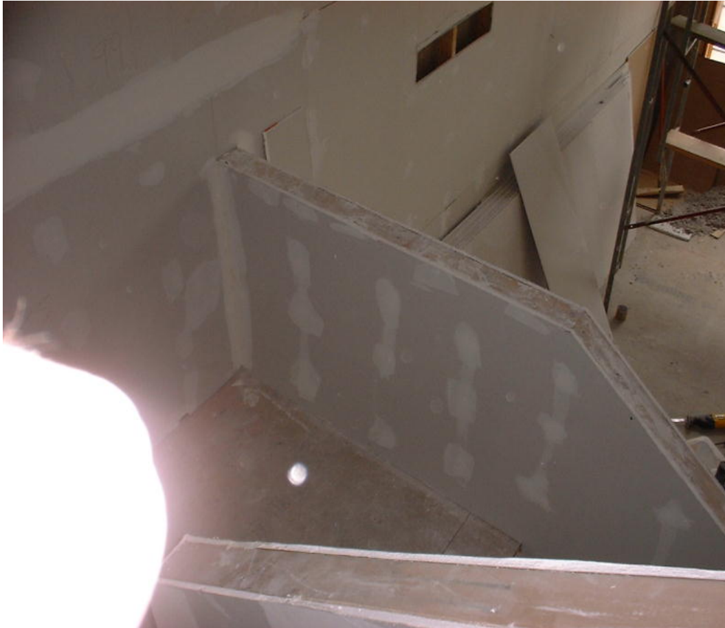
Montaż płyt - schody
