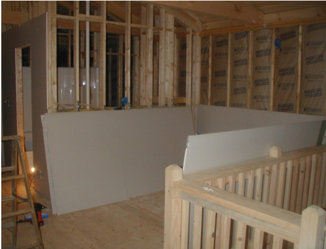
Montaż płyt – ściany
