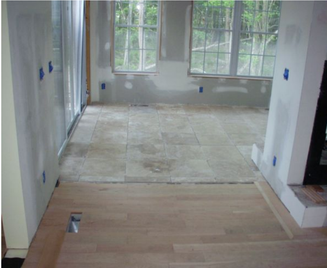
Montaż płyt - salon z korytarzem
