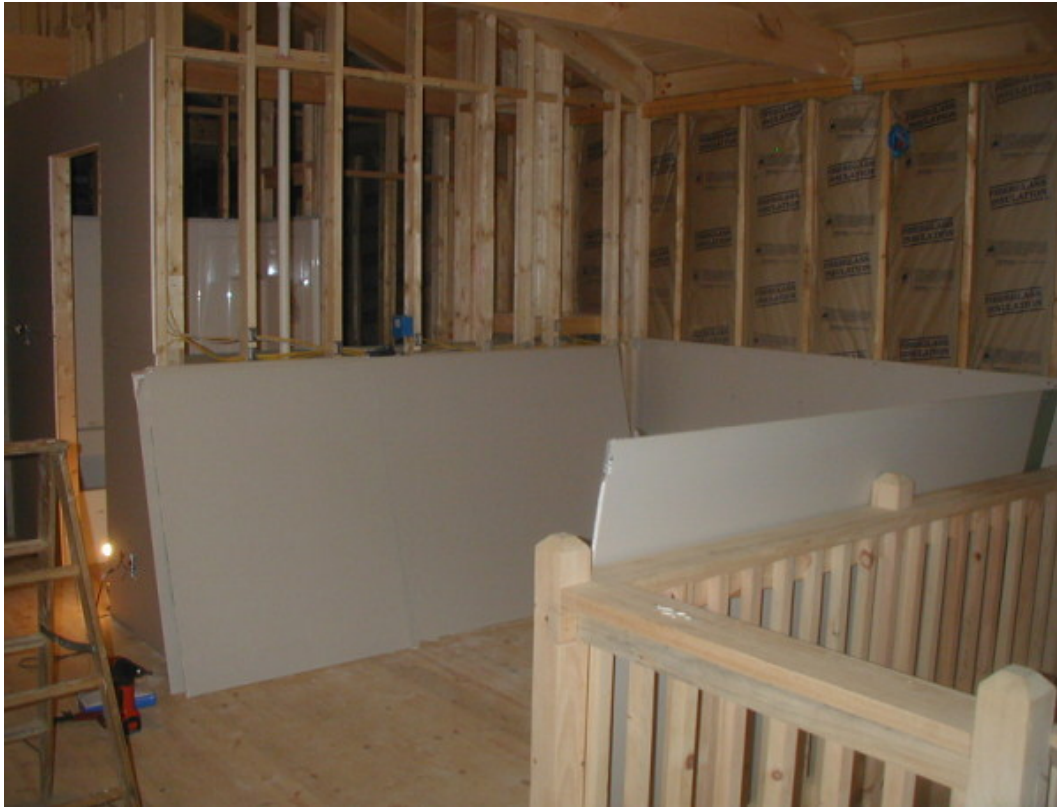
Montaż płyt – ściany
