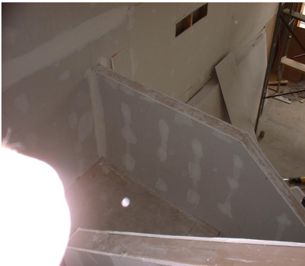
Montaż płyt - schody
