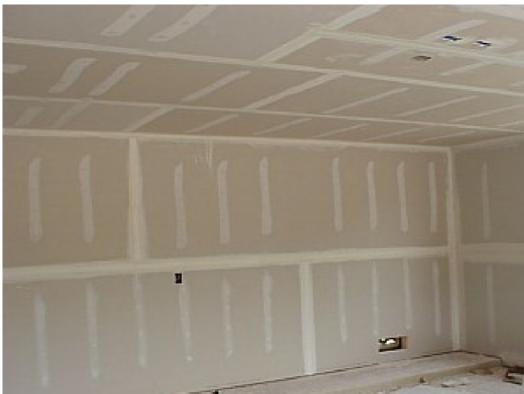
Montaż płyt – ściany i sufit
