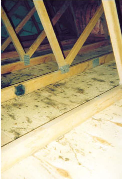
fot. 1. Elementy drewniane zniszczone przez grzyby pleśniowe z 3 klasy workowców ( Ascomycetes ) z 5 klasy grzybów niedoskonałych ( Denteromycetes )
