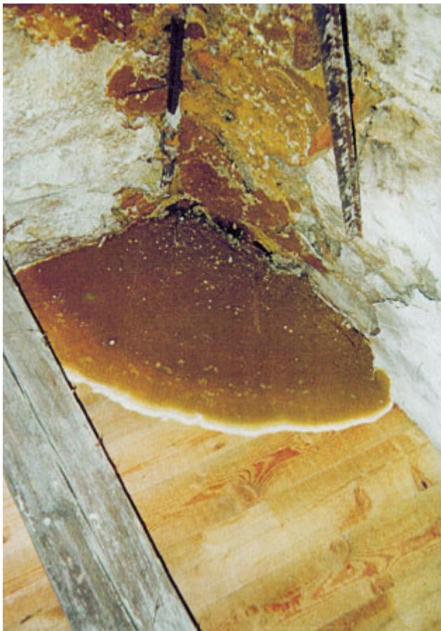
fot. 1. Elementy drewniane zniszczone przez grzyby pleśniowe z 3 klasy workowców ( Ascomycetes ) z 5 klasy grzybów niedoskonałych ( Denteromycetes )
