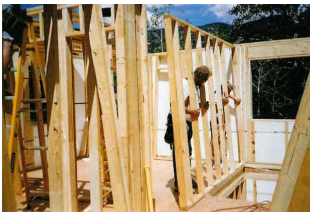
Montaż ścian działowych
