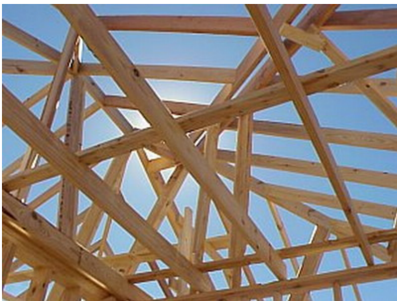
Szkielet stropu i dachu
