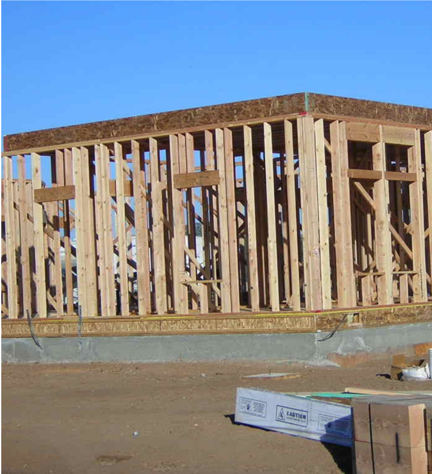
Konstrukcja ścian
