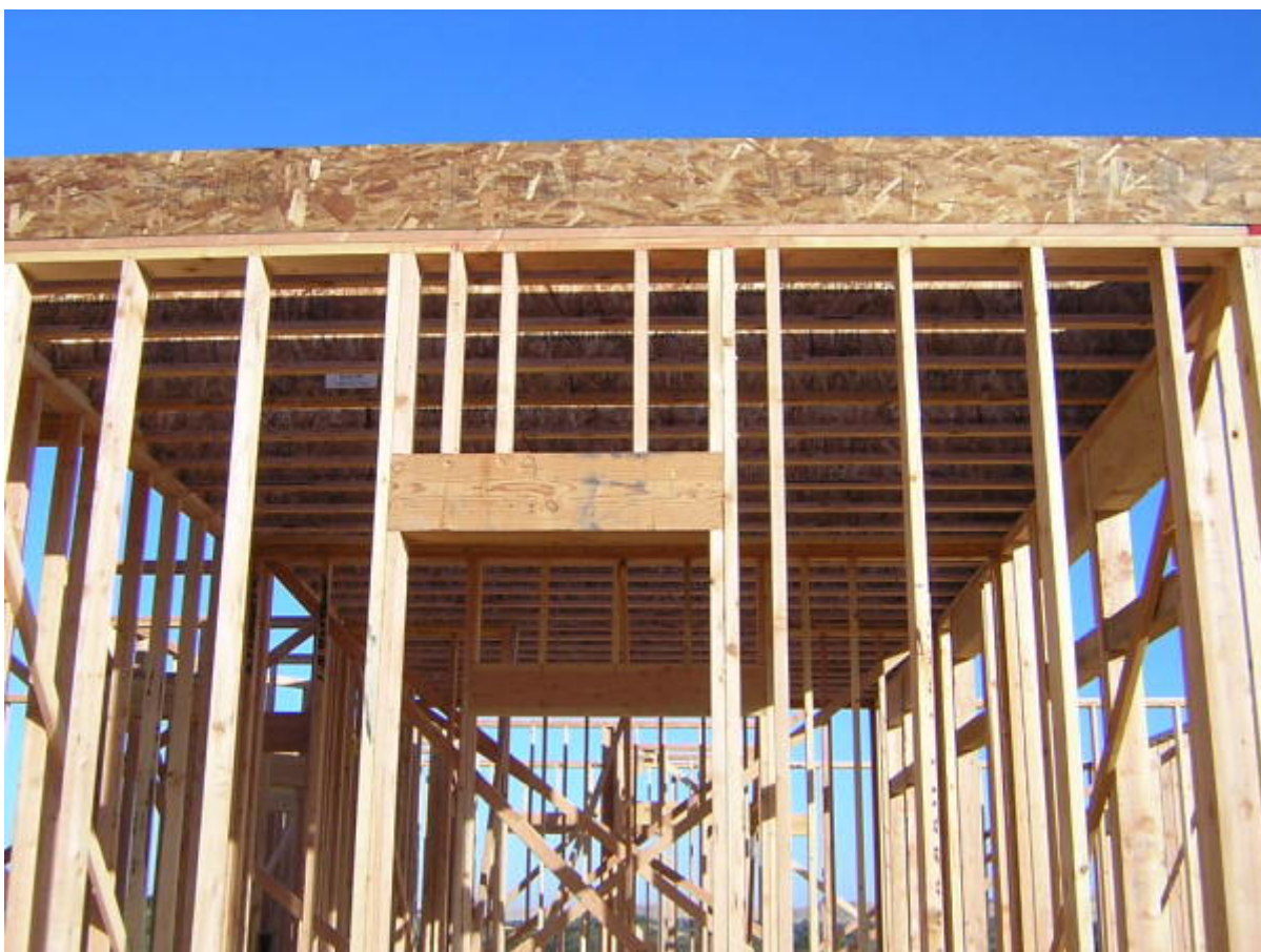
Nadproże drzwiowe zewnętrzne
