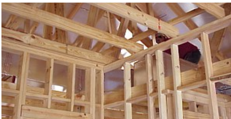
Ściany i strop
