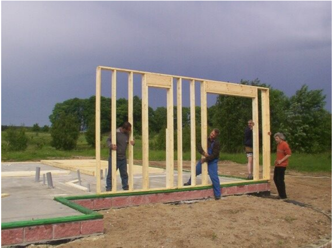
Montaż podwaliny
