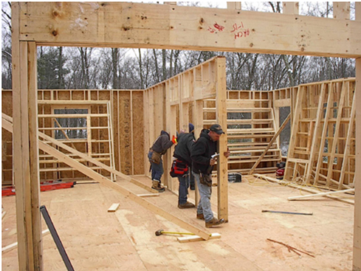
Montaż ścian
