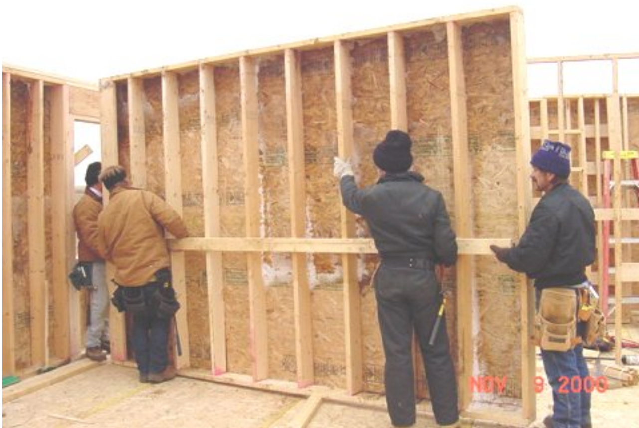
Montaż ścian działowych z płyto OSB
