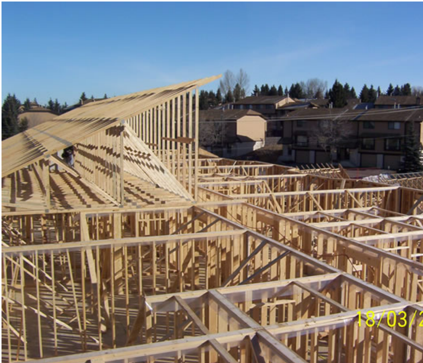
Wiązary drewniane dachu i ściany
