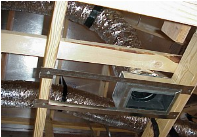
Instalacja rozprowadzenia kominka
