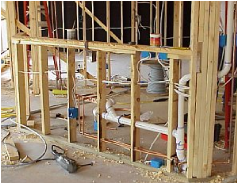
Instalacja kanalizacji i wody
