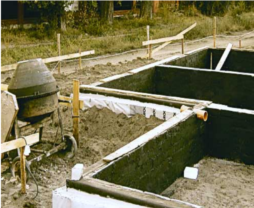
Fundamenty z bloczka Izolacja
