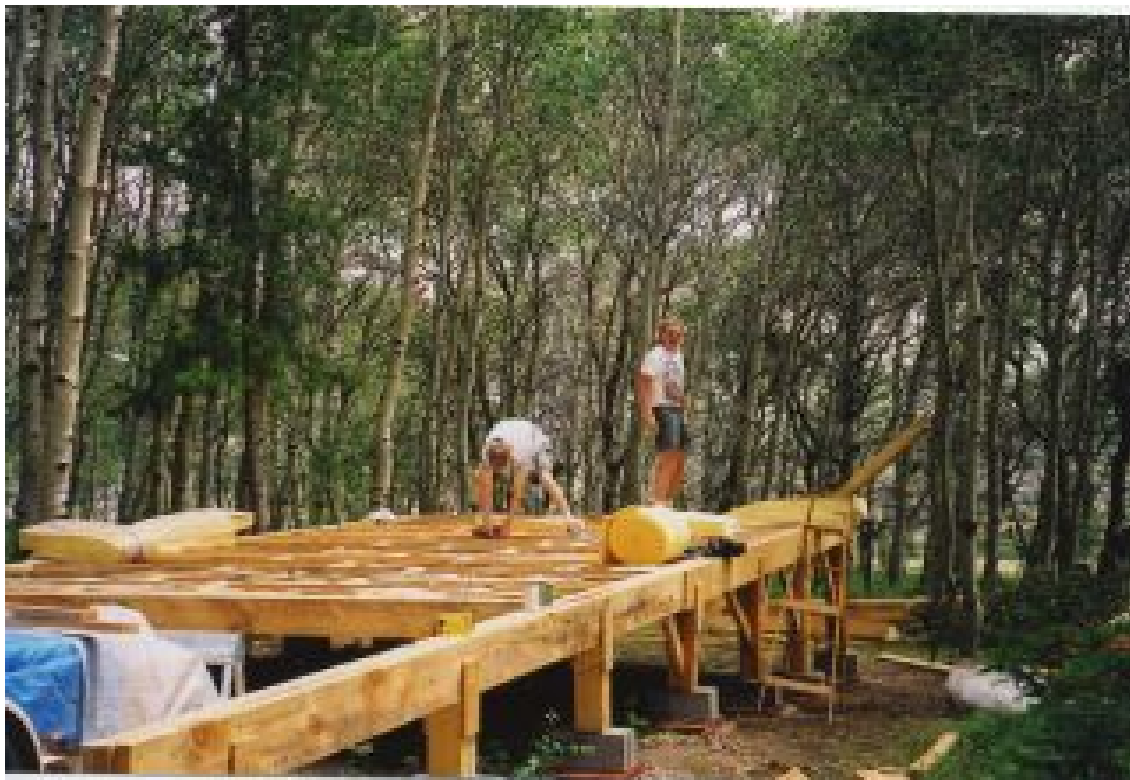
Fundamenty na słupach betonowych
