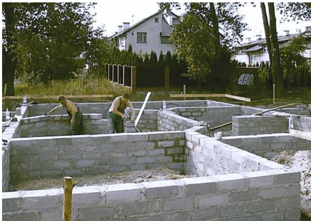
Fundamenty z bloczka betonowego
