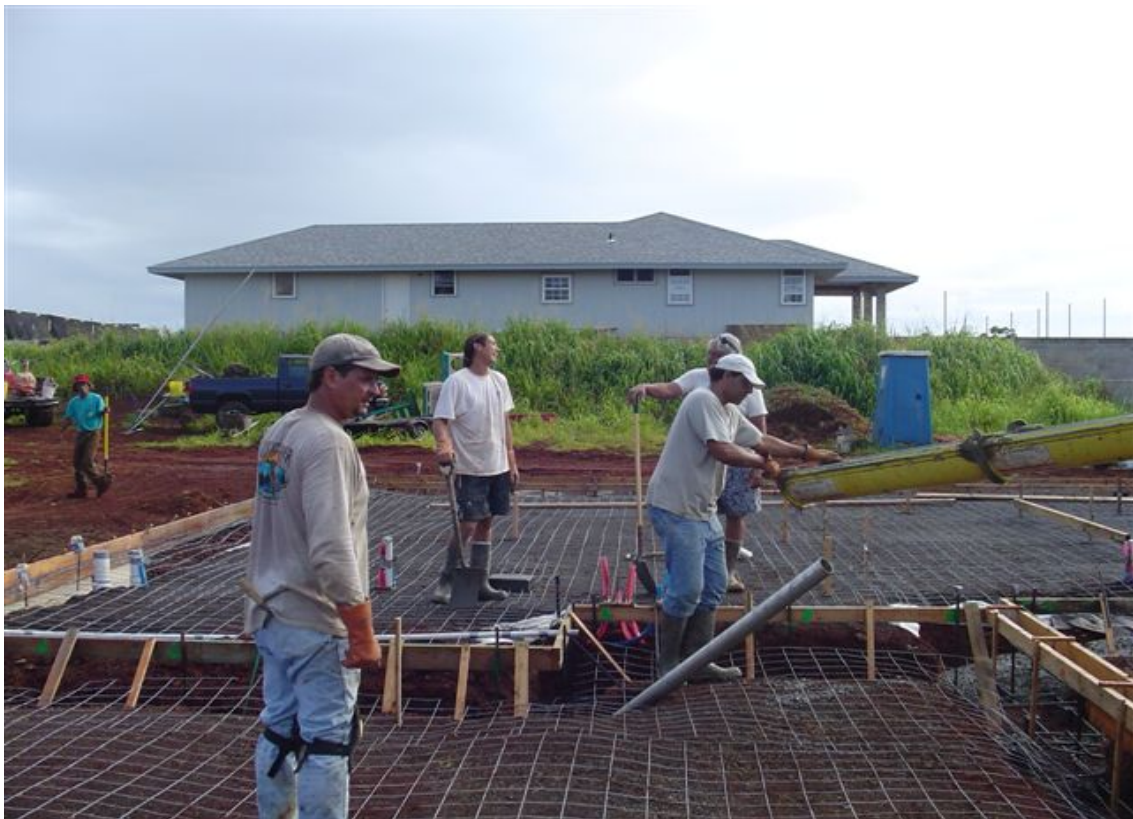
Zbrojenie płyty fundamentowej
