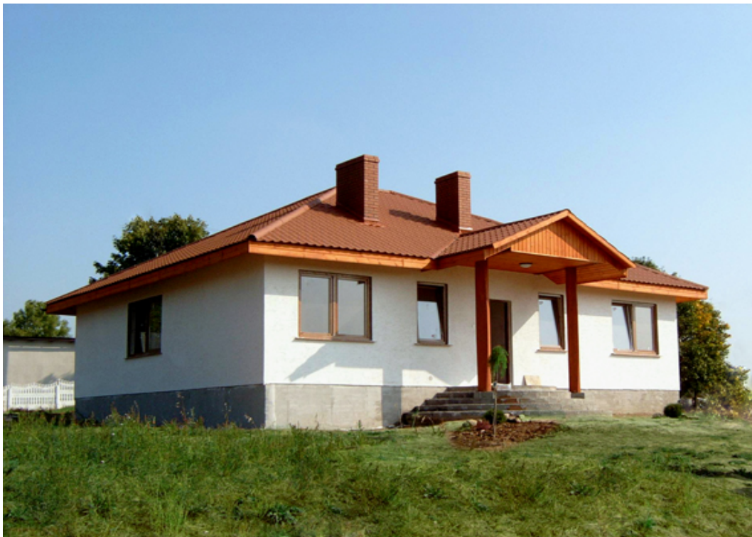
Elewacja tynk mineralny na styropianie
