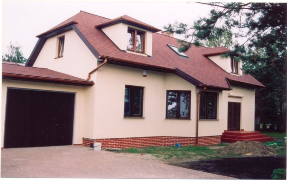
Elewacja tynk mineralny na styropianie
